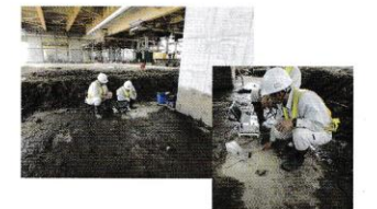
写真3:同システムによる基礎杭調査
